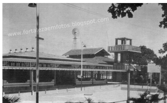
Imagem 12: Antiga sede do Ideal Clube no bairro Damas. Fonte: https://goo.gl/QxTI7i
