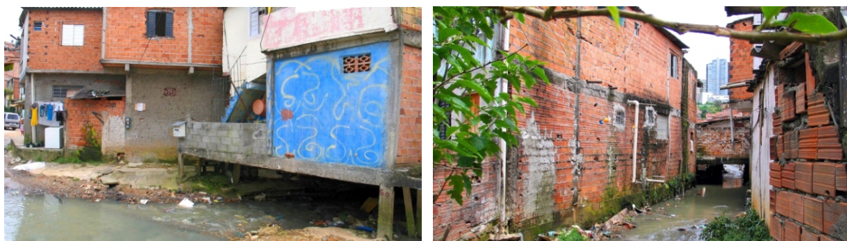
Imagem 22 e 23: Situação atual do Córrego Antonico e com construções por cima do seu leito. Fonte: Divulgação MMBB Arquitetos.
