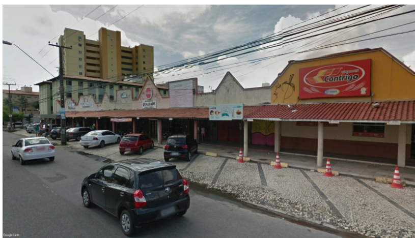
Imagem 39: Comércios e prédios residenciais na Av. João Pessoa. Fonte: Google Earth.
