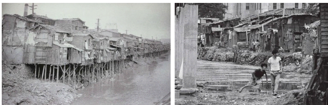
Imagem 16 e 17: O rio acabou tornando-se uma vitrine do flagelo local e representava um grande problema para o saneamento da cidade. Fonte: https://goo.gl/IzFcZw
